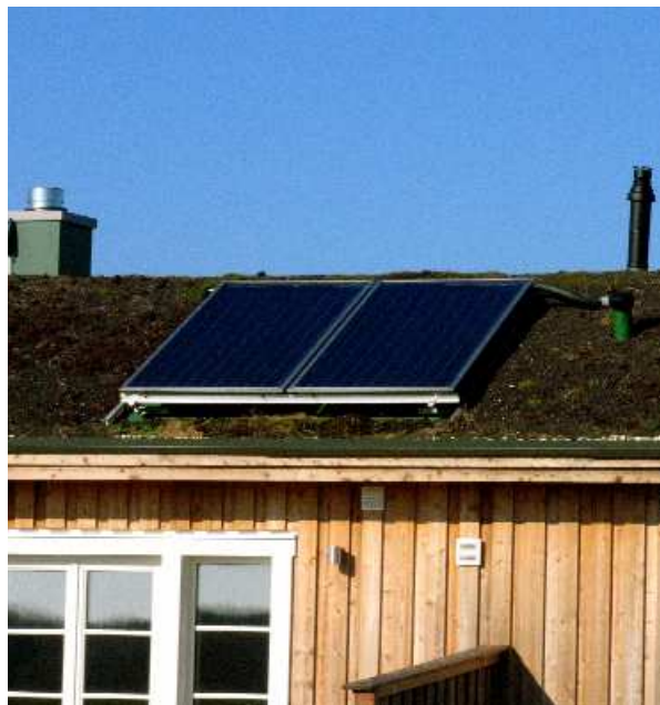
dezentrale Solarkollektoren auf den neuen Ferienhäusern (2. Bauabschnitt)
